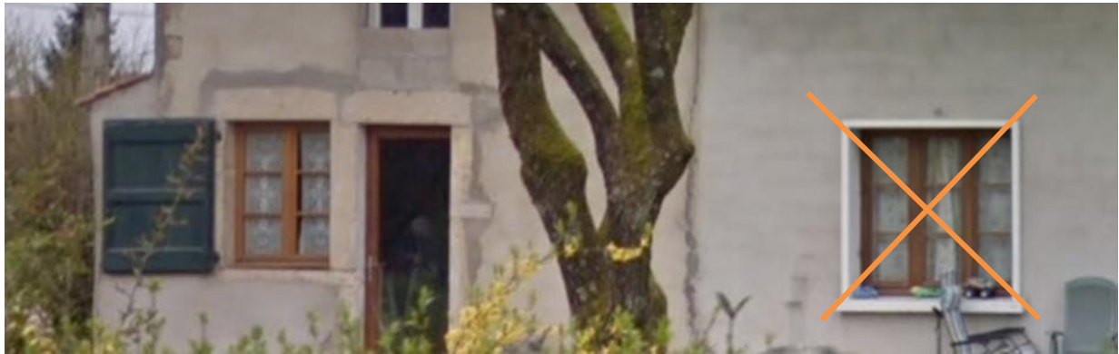
Exemple d'une nouvelle ouverture qui ne respecte pas les proportions anciennes
